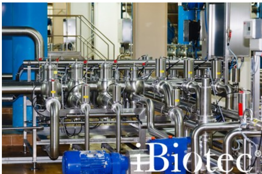
Purga de canalizaciones
